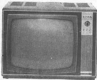
**Barcolor CX22/P.** Même modèle, équipé pour les canaux VHF français, belge et luxembourgeois 819 lignes, belge et flamand et CCIR 1<sup>re</sup> chaîne 625 lignes, et UHF français et CCIR 2<sup>e</sup> chaîne, décodeur couleurs système PAL incorporé. 9 tubes, 60 transistors. Consommation 230 VA. Autres caractéristiques identiques.
